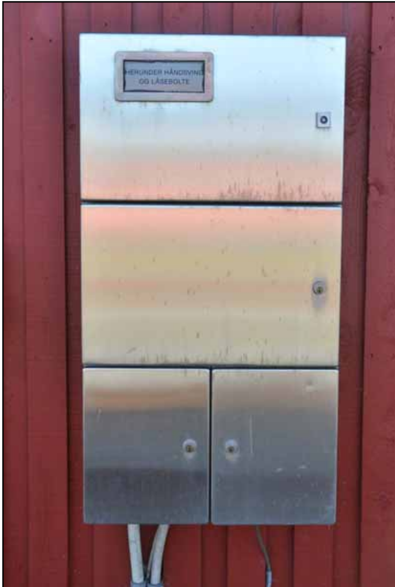
Betjeningsskab type DSB 1954 PAPP, lukket
