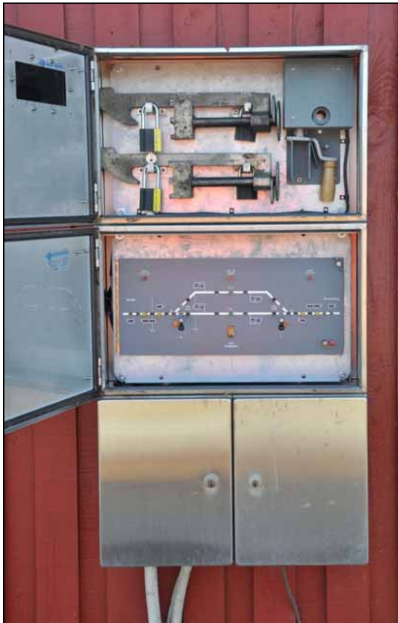
Betjeningskab type DSB 1954 PAPP, åbent
