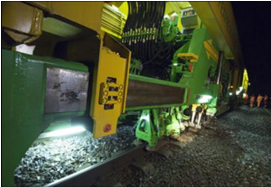
Figur 4. Sporjusteringsmaskine ved dagslys og i mørke.
