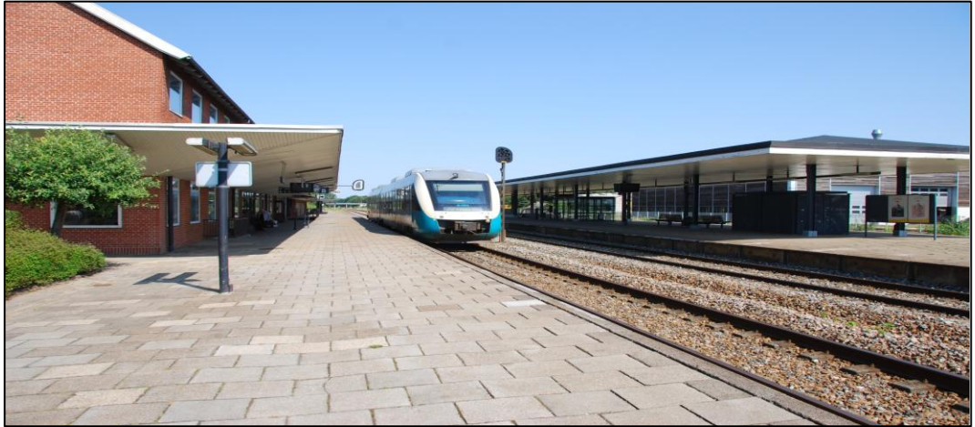
Figur 28. Foto af Langå Station set mod nord. Stationsbygningen ses til venstre i billedet.
