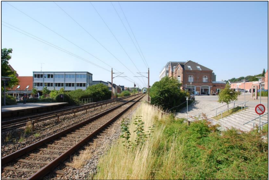
Figur 60. Visualisering af Hadsten Station og landsby efter opstilling af kørestrømsmaster. Kig mod nordvest. Beplantning i form af buske og træer på begge sider af banen er beskåret og fjernet.
