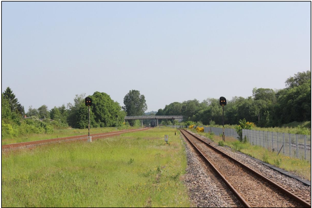
Figur 65. Broen ved Væthvej (bro nr. 20978, km 154+840, Randers Kommune). Kig mod nord.
