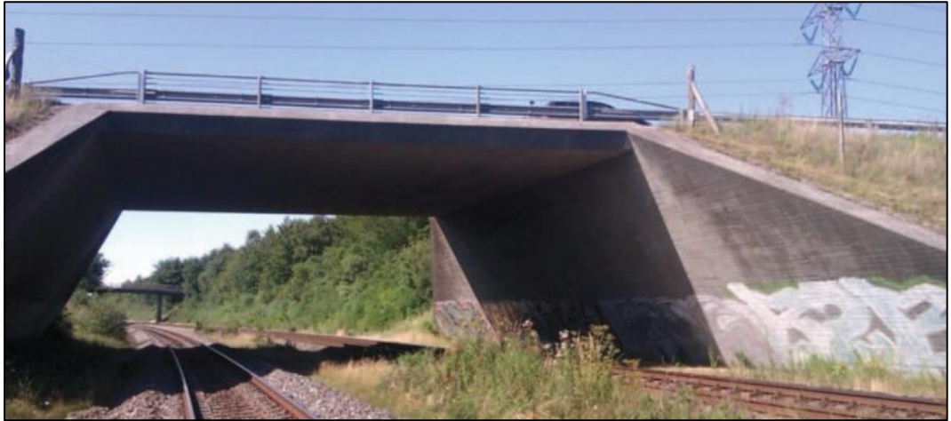
Figur 44. Vejbærende rammebro, Edwin Rahrs Vej vest for Aarhus.
