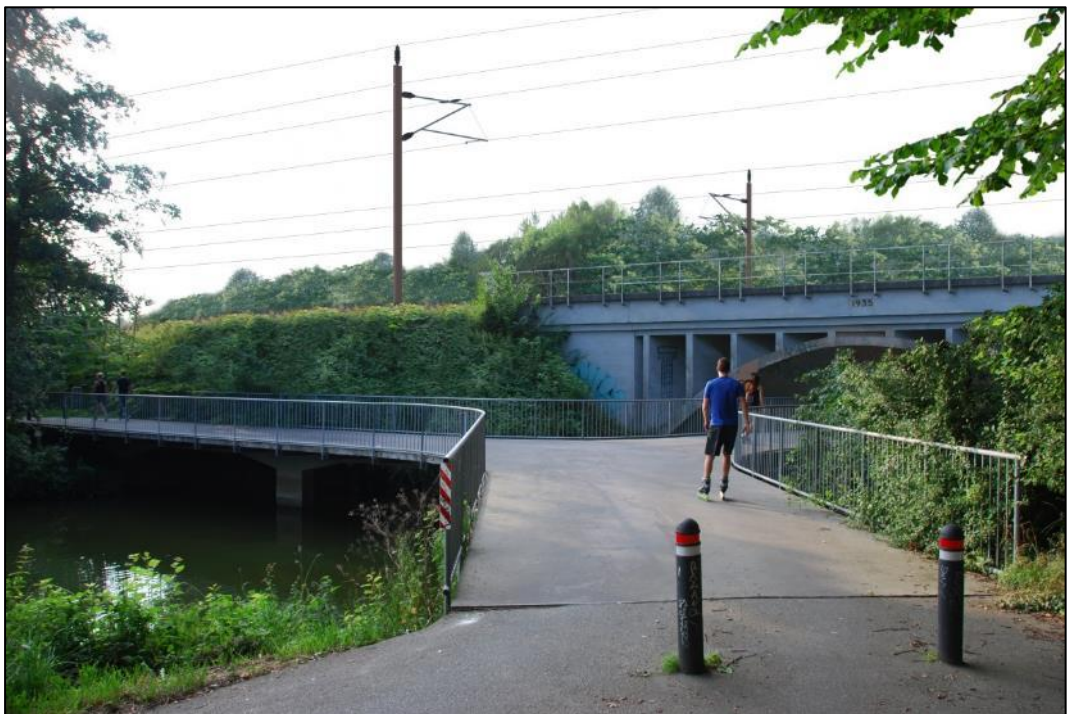
Figur 46. Visualisering af jernbanebroen med kørestrømsanlæg over Aarhus Å og Brabrandstien i Aarhus. Kig mod nordvest. Beplantning i form af buske og træer på begge sider af banen er beskåret og fjernet. Banedæmningen fremstår tydeligere og fremhæves af kørestrømsanlægget.
