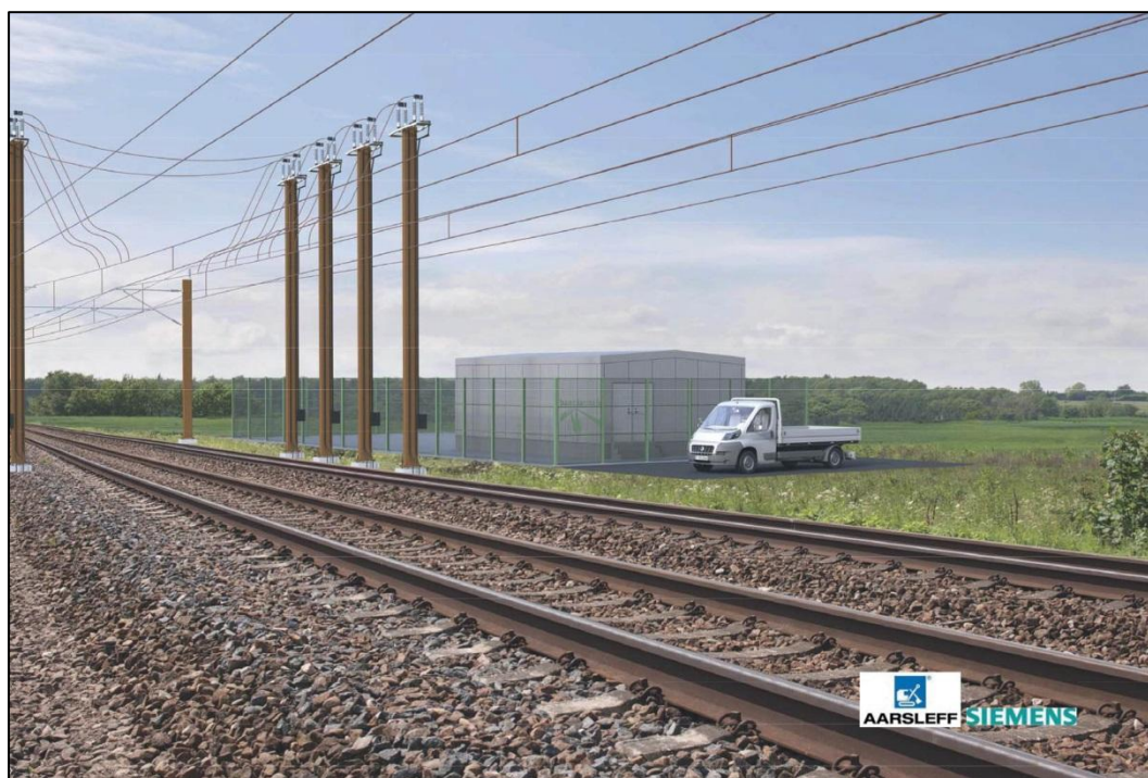
Figur 69. Visualiseringen viser et eksempel på en autotransformerstation i åbent land. Visualiseringen er en principillustration lavet af leverandør (Aarsleff / Siemens).
