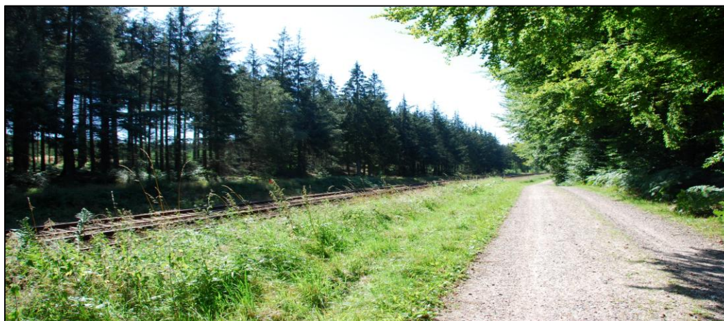
Figur 22. Foto med blik mod syd i Rold Skov, hvor en grusvej forløber parallelt med banen. Høje nåle- og løvtræer står tæt på banen.
