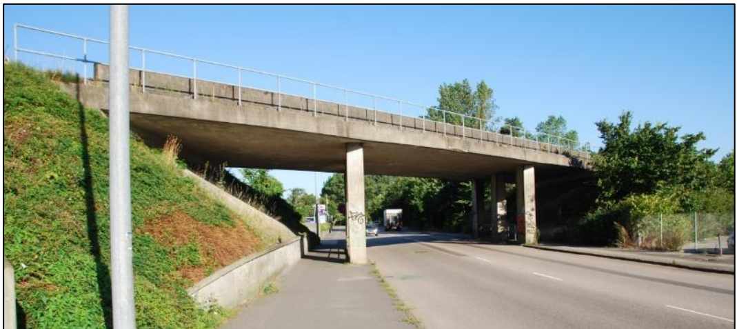
Figur 39. Sporbærende tre-fags bjælkebro over Strandvejen i Aalborg.
