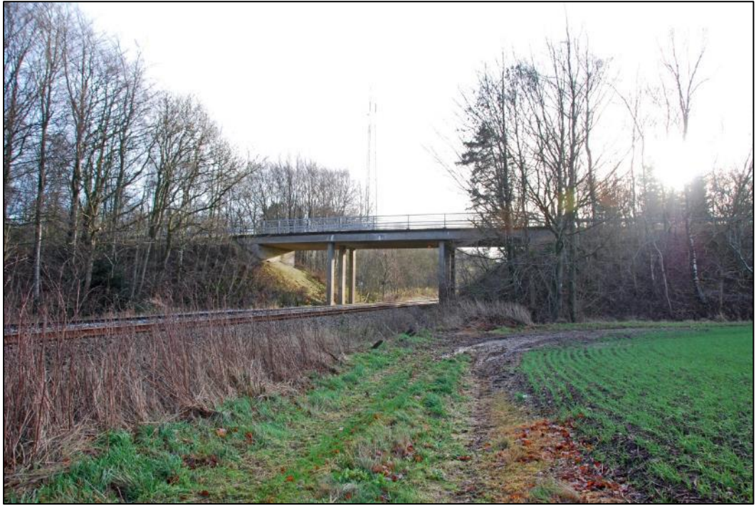
Figur 63. Broen ved Klejtrupvej (bro nr. 21066, km 192+610, Mariagerfjord Kommune). Kig mod syd.
