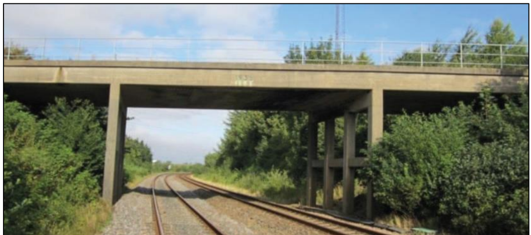
Figur 43. Vej- og stibærende tre-fags bjælkebro, Selkærvej vest for Aarhus.
