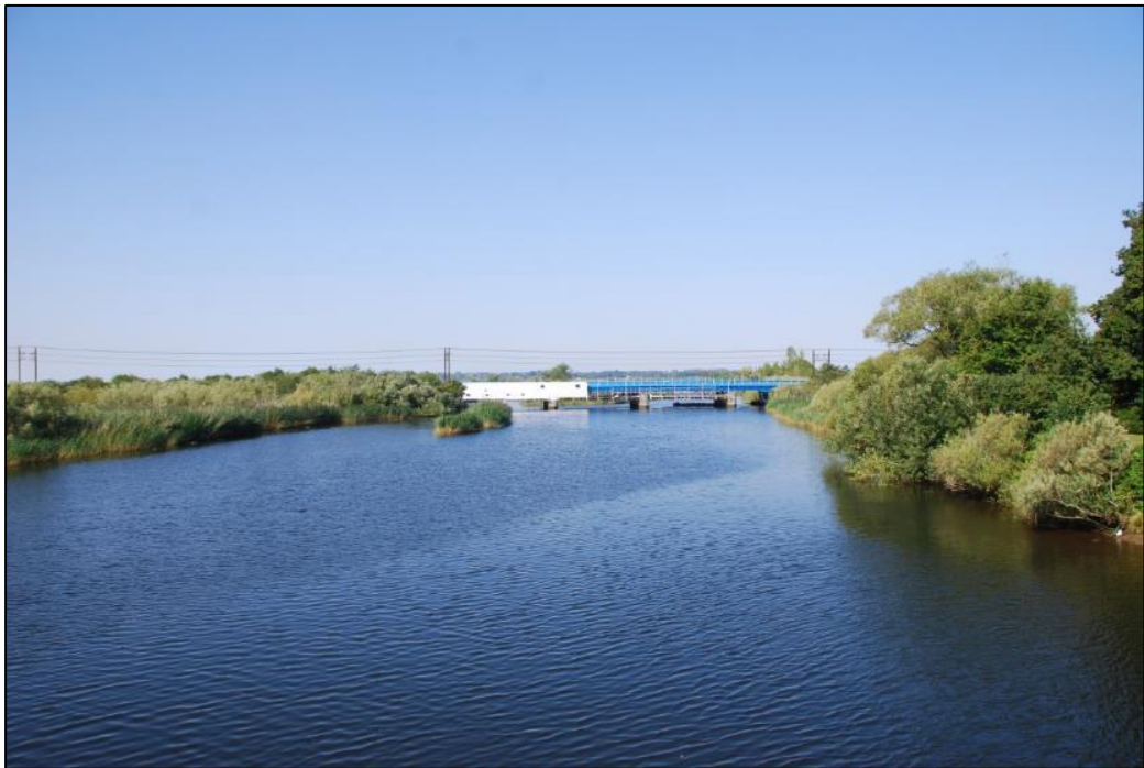
Figur 50. Visualisering af jernbanebroen med kørestrømsanlæg over Gudenåen ved Randers. Kig mod vest. Beplantning i form af buske og træer på begge sider af banen er beskåret og fjernet. Kørestrømsledningernes lige linje udgør en kontrast til den underliggende, bølgede vegetation.
