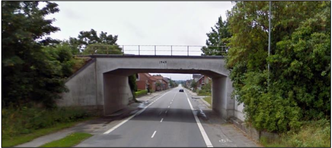
Figur 40. Sporbærende rammebro over Viborgvej ved Sønder Onsild Stationsby.
