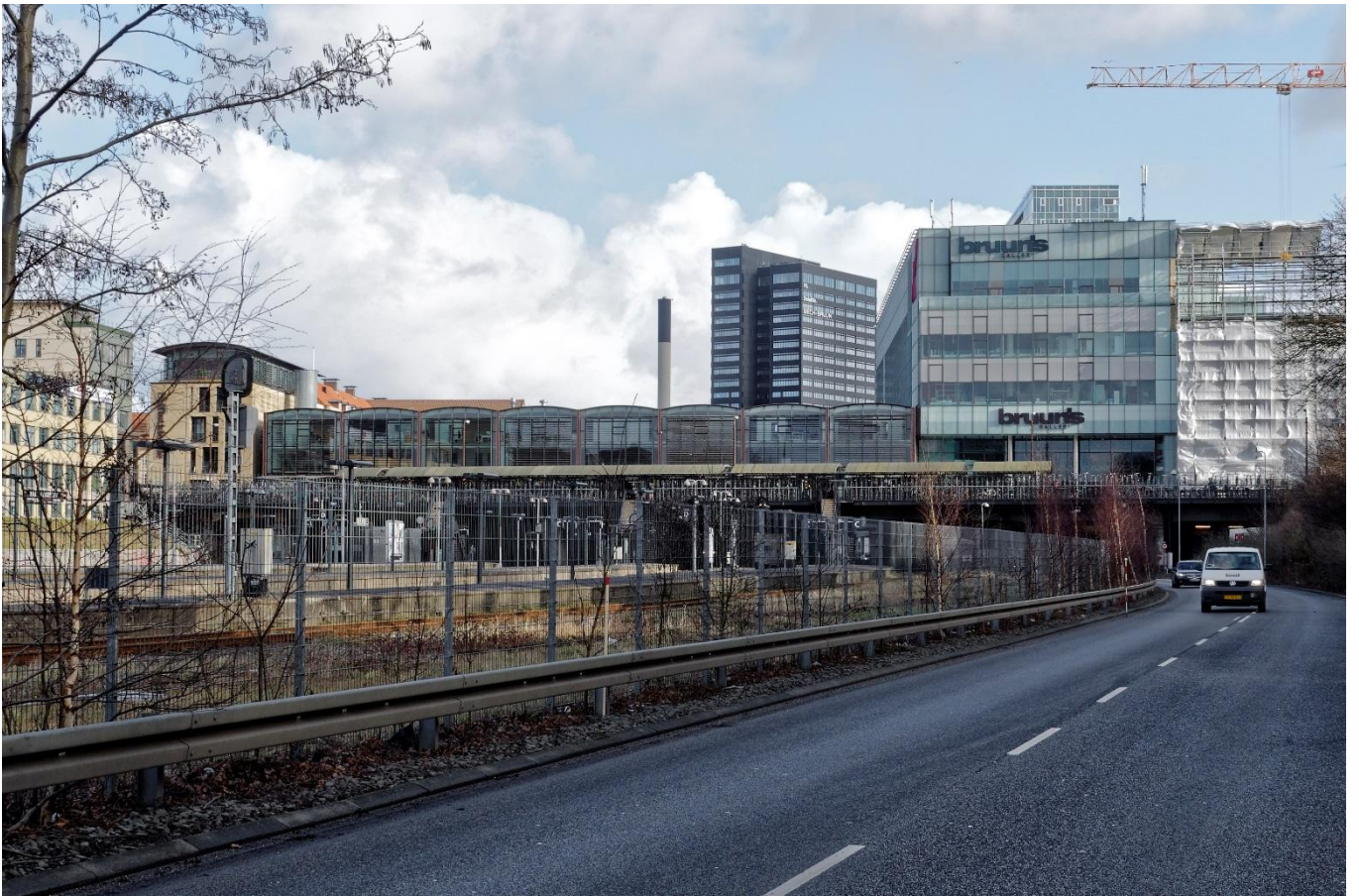
Figur 6 Fotostandpunkt nr. 3. Eksisterende forhold set fra Værkmestergade vest for Aarhus Hovedbanegård. (Foto: COWI)
