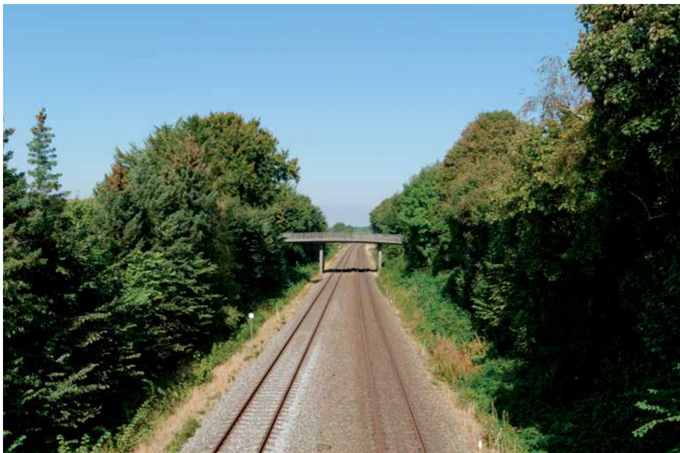
Flere broer langs strækningen i dag er for lave. Desuden er der oftest høj beplantning langs banen.
